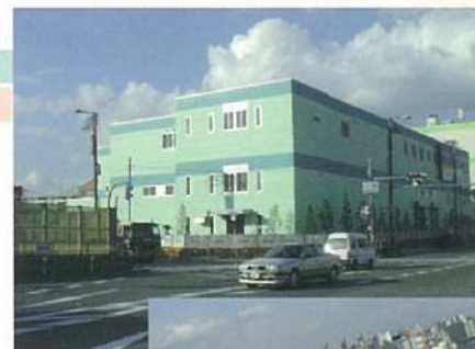
新しく集約化される レンタル工場
